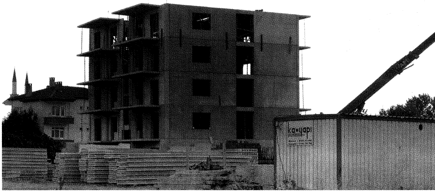
Abb. 5: Im Bau befindliches Haus
